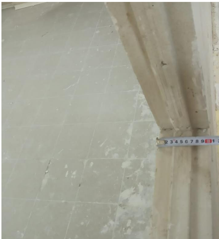
Фото 1. Изготовление фрагмента перегородки в акустической камере, (плиты гипсовые пазогребневые полнотелые ПлГН2 размером 667x500x100)
