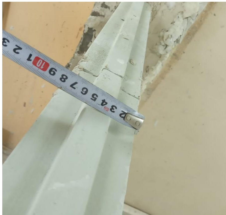
Фото 1. Изготовление фрагмента перегородки в акустической камере, (плиты гипсовые пазогребневые полнотелые гидрофобизированные ПЛГН1 размером 667x500x80)
