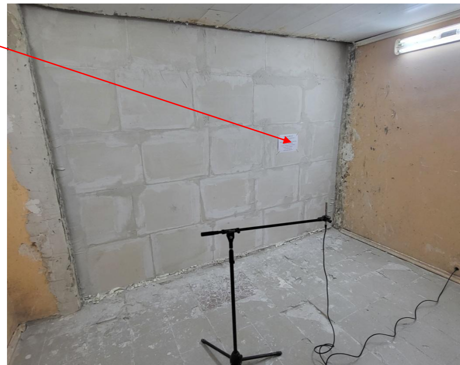
Фото 2. Камера низкого уровня, испытание фрагмента перегородки регистрационный № 4982-25
